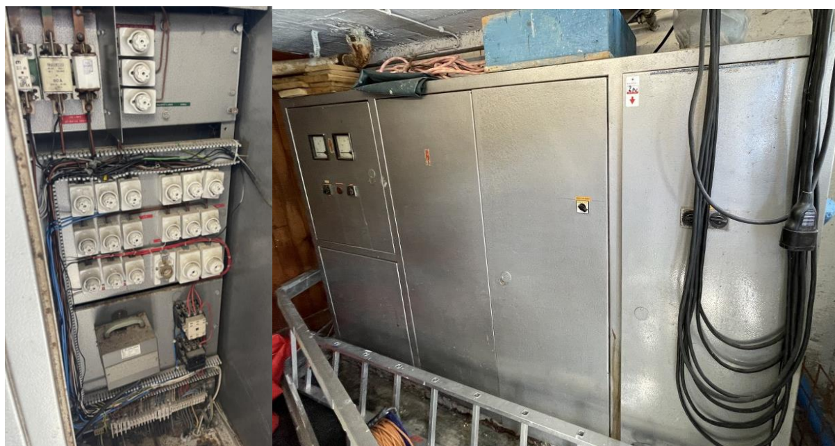
Slika 23: Zastarele elektro omarice v kleti športne dvorane
