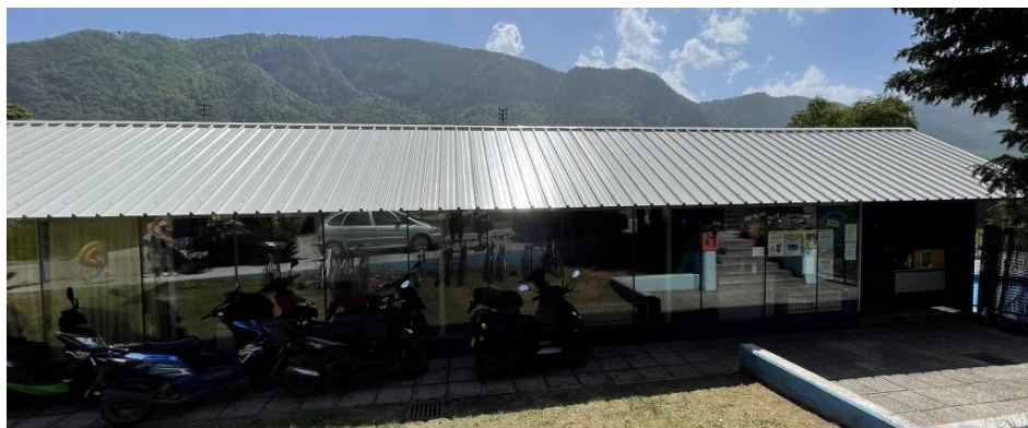
Slika 28: Strešna konstrukcija športne dvorane
