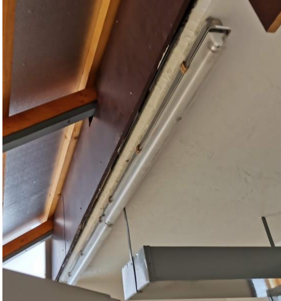
Slika 35: Halogenske sijalke z nazivno močjo 40 W v športni dvorani
