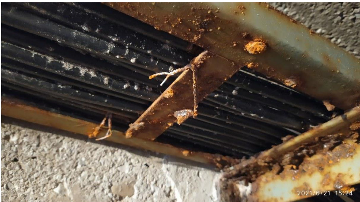
Slika 25: Potencialna nevarnost električnega udara
