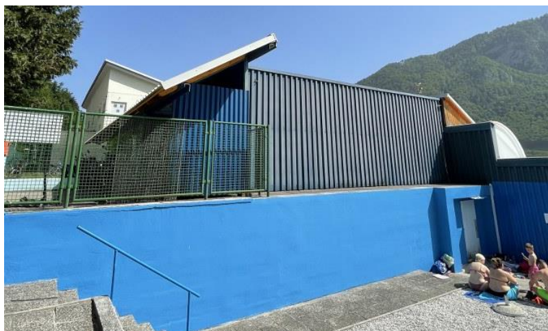
Slika 27: Severna stran športne dvorane
