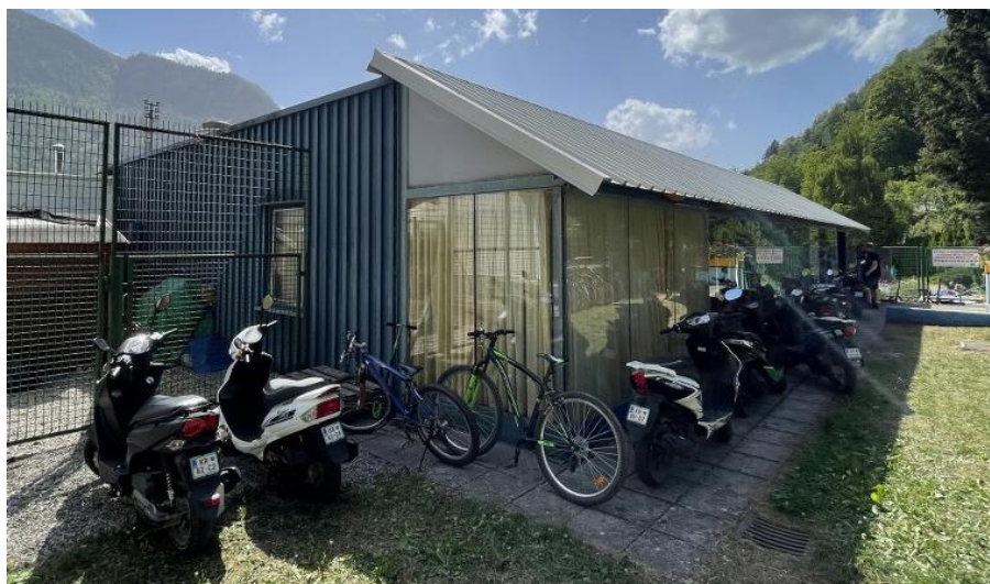
Slika 26: Vzhodna stran športne dvorane
