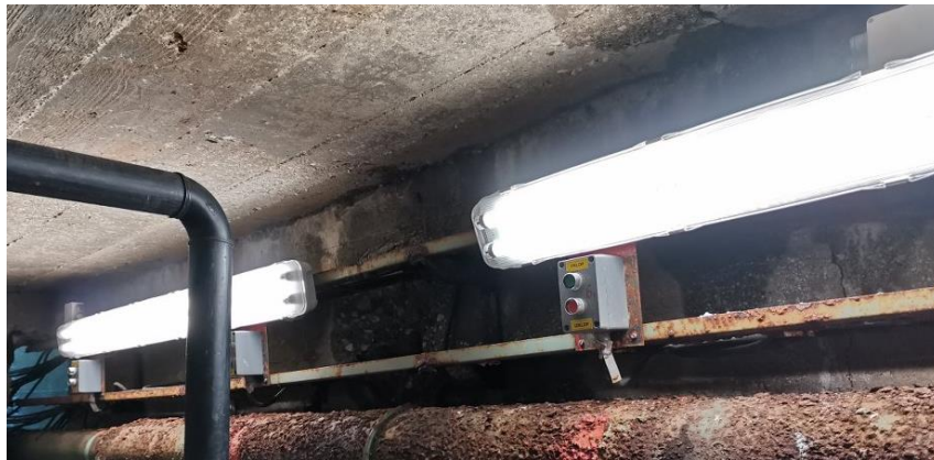
Slika 36: Fluorescentne sijalke tipa T8 pod bazenom
