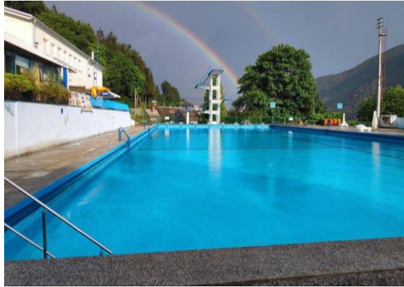
Slika 1: Olimpijski bazen s skakalnim stolpom
