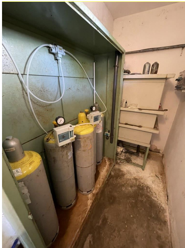
Slika 19: Jeklenke za doziranje plinskega klora z regulatorji
