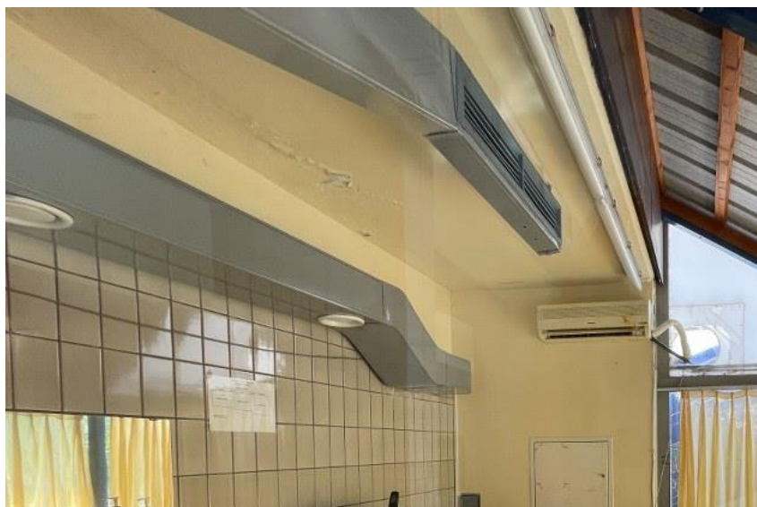
Slika 22: Prezračevanje in SPLIT notranja enota
