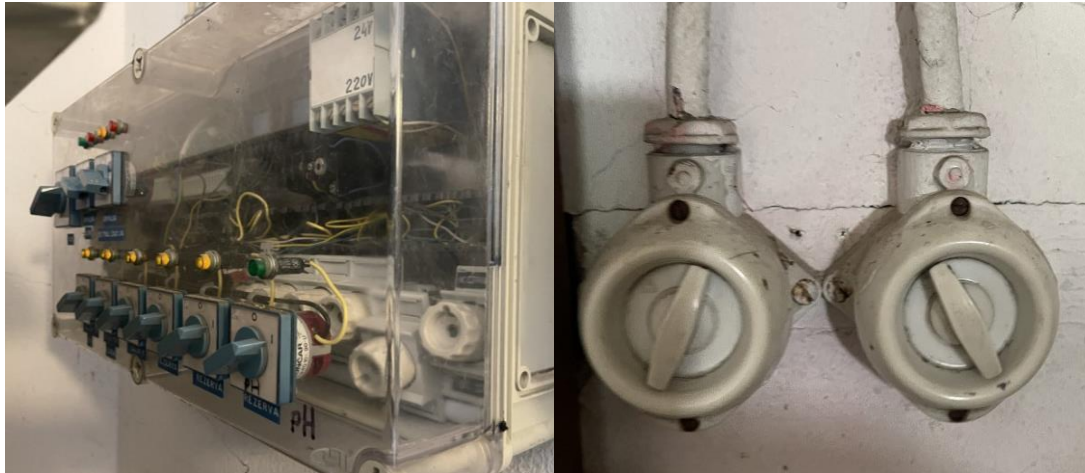
Slika 24: Zastarela elektro omarica in stikala v toplotni postaji
