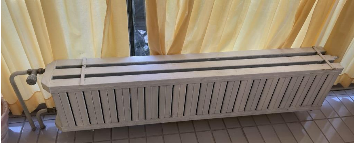
Slika 20: Radiatorji nimajo termostatskih ventilov s termostatskimi glavavami
